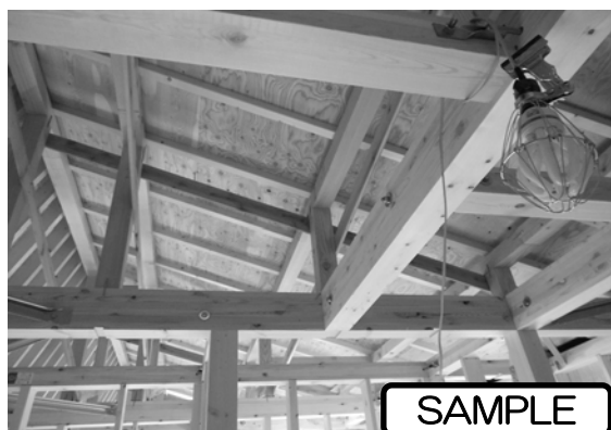
小屋組の全景
